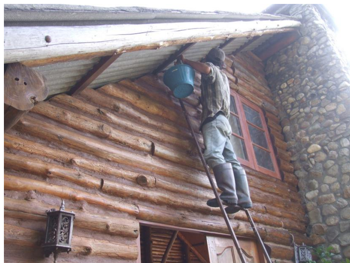
ซ่อมแซมหลังคาที่ประทับ
